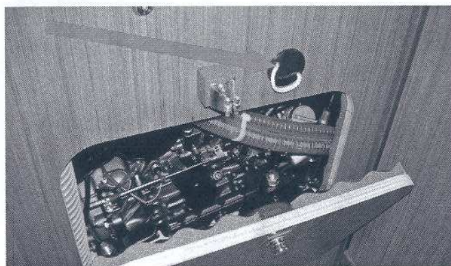
ORIFICE EXTINCTEUR - CABINE ARRIÈRE
